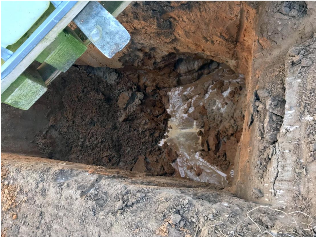
Foto 1: zulaufendes Schichtenwasser bei -1,1 m u. GOK in Schurf 2
