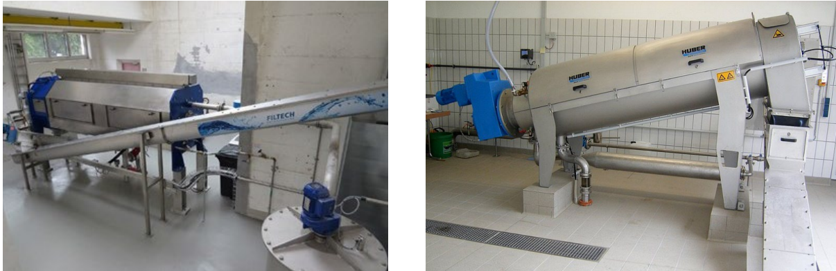
Abbildung 12: Beispiele einer Schneckenpresse zur stationären Klärschlamm-Entwässerung der Hersteller IEA (links) und Huber (rechts) (Quelle: IEA Derflinger GmbH und Huber SE)
