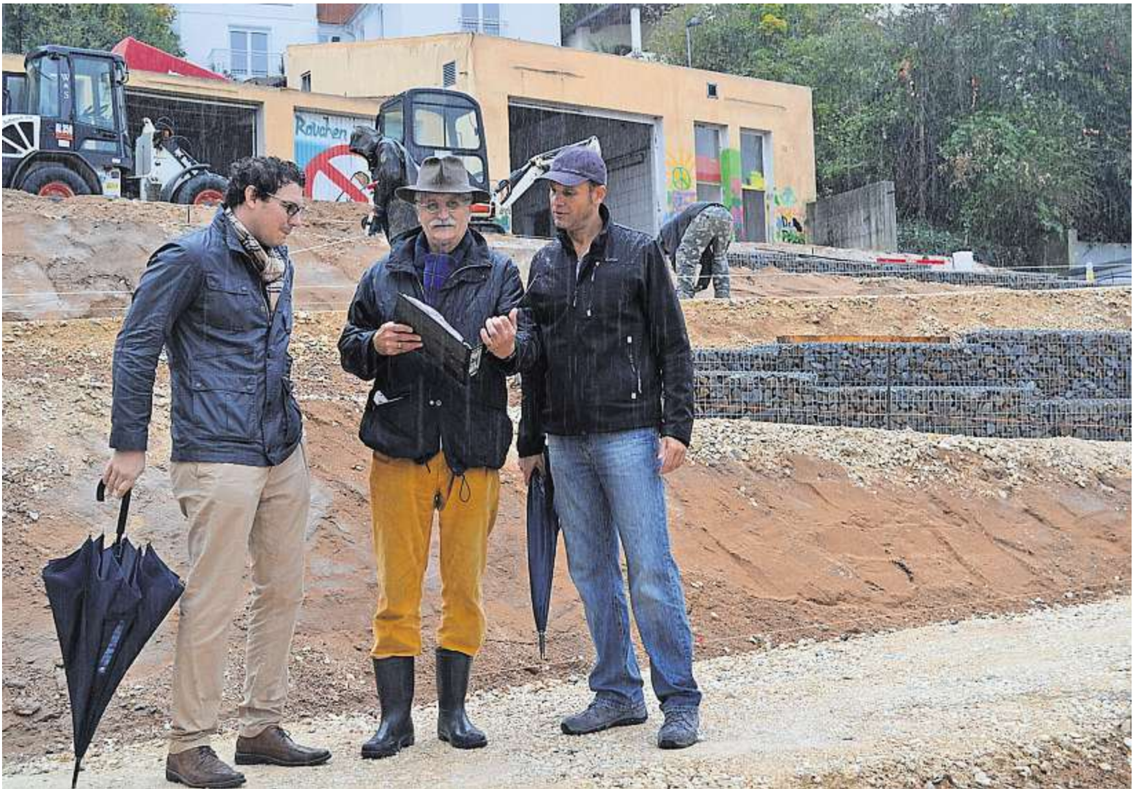
Einmal jede Woche ist „Jour fixe“ an der Baustelle auf dem künftigen Mehrzweckplatz beim Kulturhaus. Christoph Hüttl (links) und Christian Kotschate (rechts) von der Marktverwaltung besprechen sich mit Stadtplaner Dr. Emil Lehner. Fotos: Norgall
