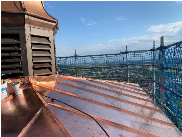
BU: Das neue Kupferdach des Turms funkelt in der Sonne. Foto: Martin Sauer, Markt Regenstauf
