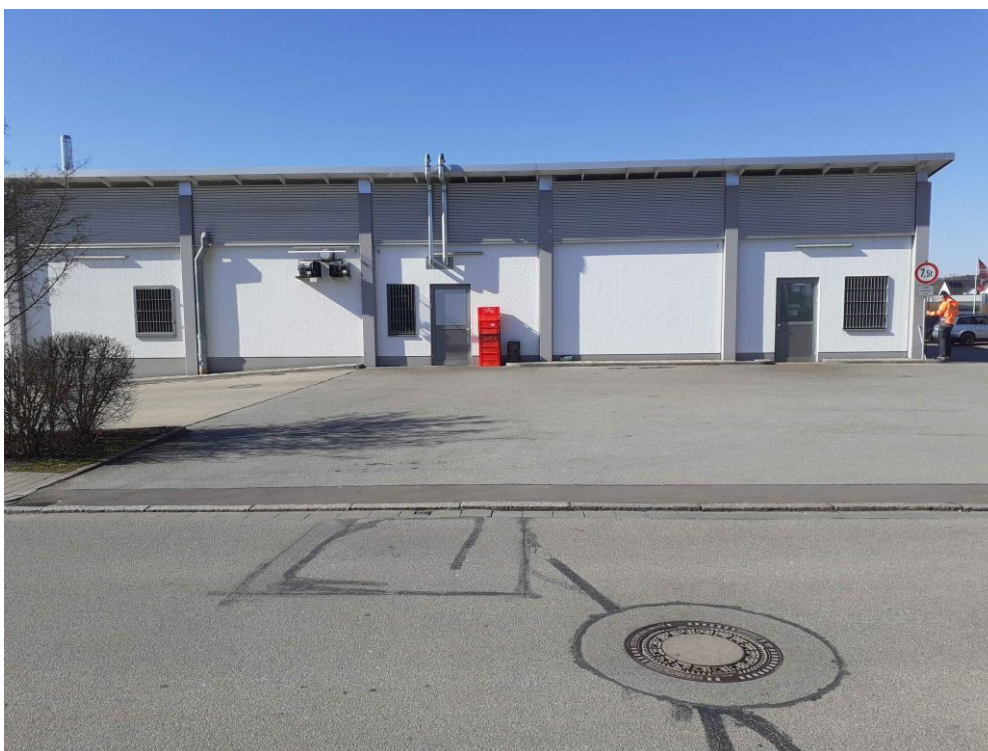
Blick auf die Ostfassade des Discounters
