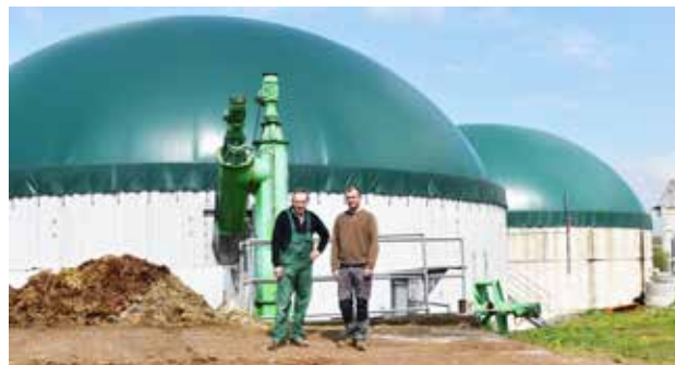
Biogasanlage Graf, Sabine Norgall
