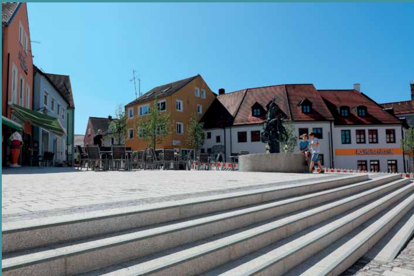
Im Bereich um den Brunnen sind die Treppenanlage und die Pflasterarbeiten fertiggestellt. Dort ist bereits erkennbar, wie sich der Platz nach Abschluss der Arbeiten präsentiert.
