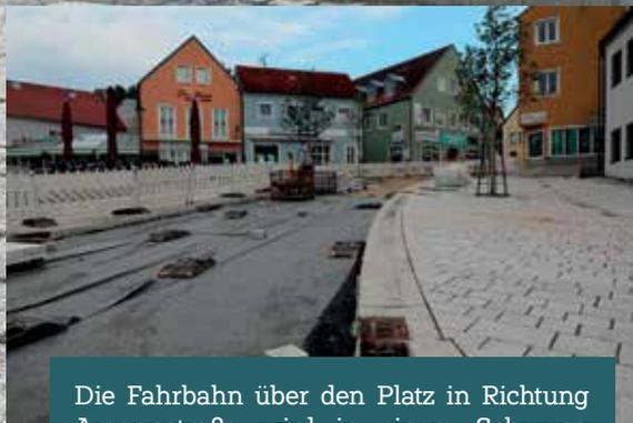
Die Fahrbahn über den Platz in Richtung Amannstraße wird in einem Schwung gepflastert. Die Fugen zwischen den einzelnen Steinen werden mit Zement ausgefüllt, sodass eine kompakte Fahrbahn entsteht.
