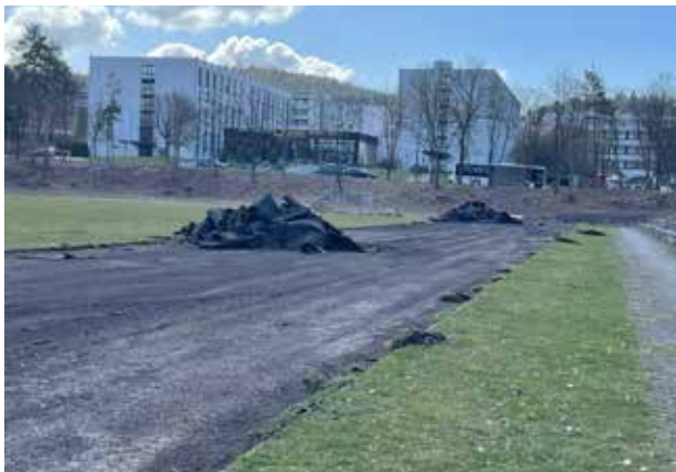
Die Bauarbeiten am Stadion haben begonnen. Als erstes wurden die Laufbahnen demontiert.
