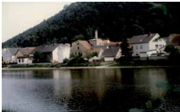
Aufnahme des Bürgerbräus (Mitte) kurz vor Abbruch großer Teile des Gebäudes um 1996
